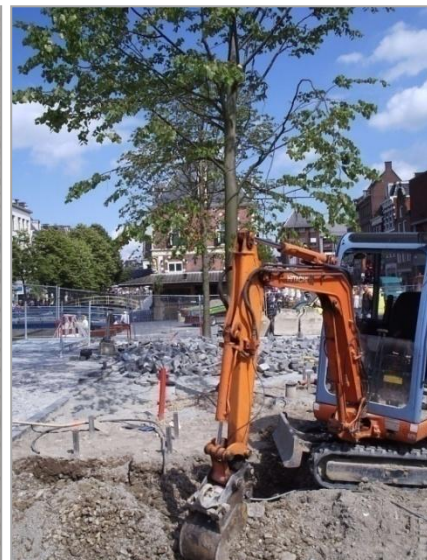
Foto 4: aanbrengen bomengranulaat rond bestaande bomen
